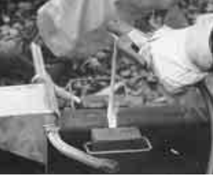
Schienenschweißen mit Kokillen: OK 74.78, OK 48.30
