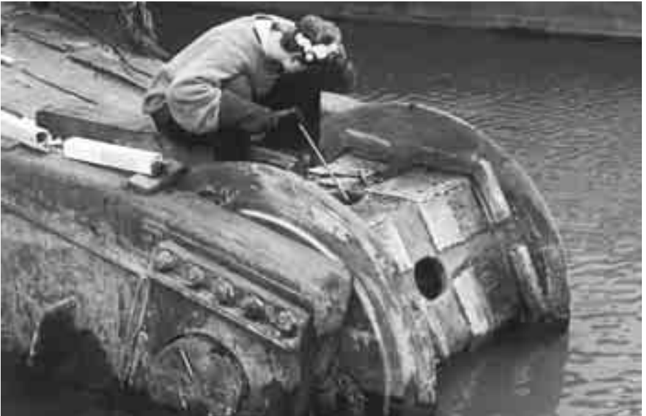
Auftragschweißen eines Eimerkettenbaggers mit OK 84.84. Aufbaulagen mit OK 83.28
