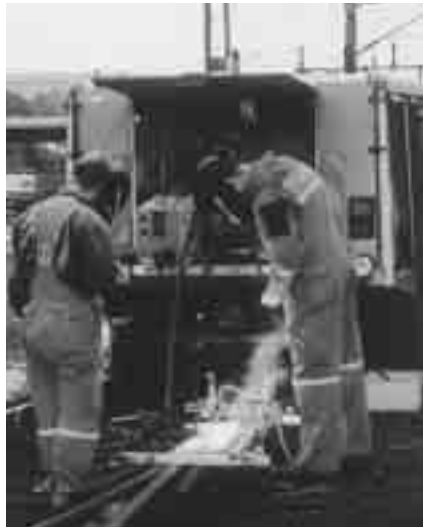
Automatisiertes Schweißen: Railtrac BV und OK Tubrodur 15.43
