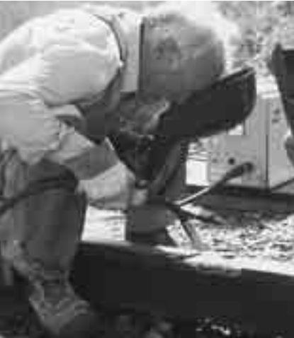
Radreparatur: OK Tubrodur 15.43
