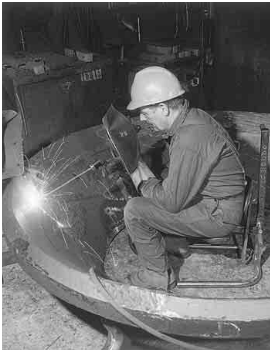
Reparatur eines 14%-Manganhartstahlbrechers mit OK 86.08
