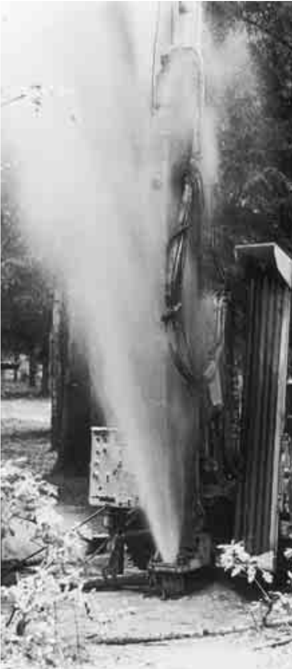
Reparatur von Erdbohrinsätzen: OK 83.28 für den Aufbau, OK 84.84 für das Hartbeschichten
