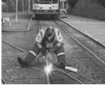
Straßenbahnschienenreparatur: OK 67.52, OK 67.43
